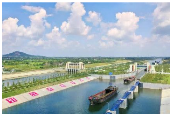
庐江节制闸船闸
