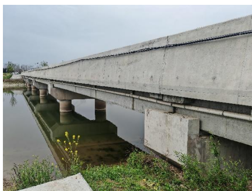
北闸桥径流收集管
