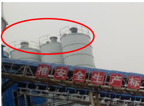
料仓配套安装除尘器
