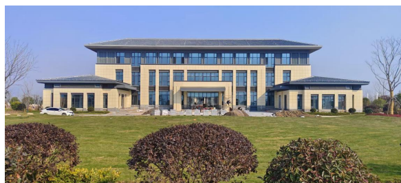
枞阳枢纽管理用房
