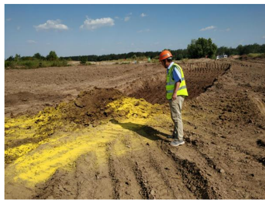
监理人员查看药物混合情况
