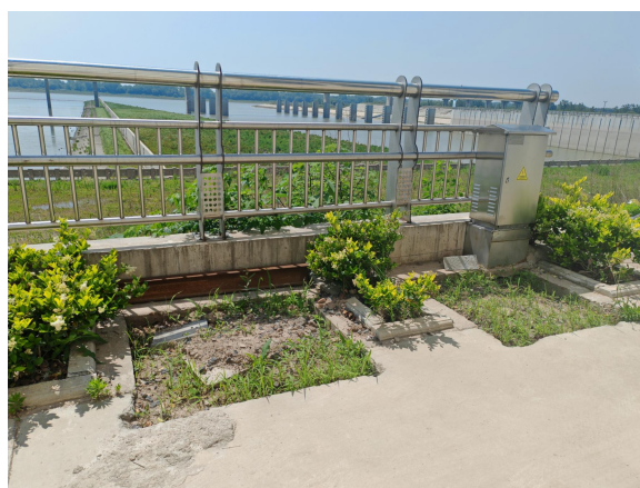
枞阳泵站化粪池
