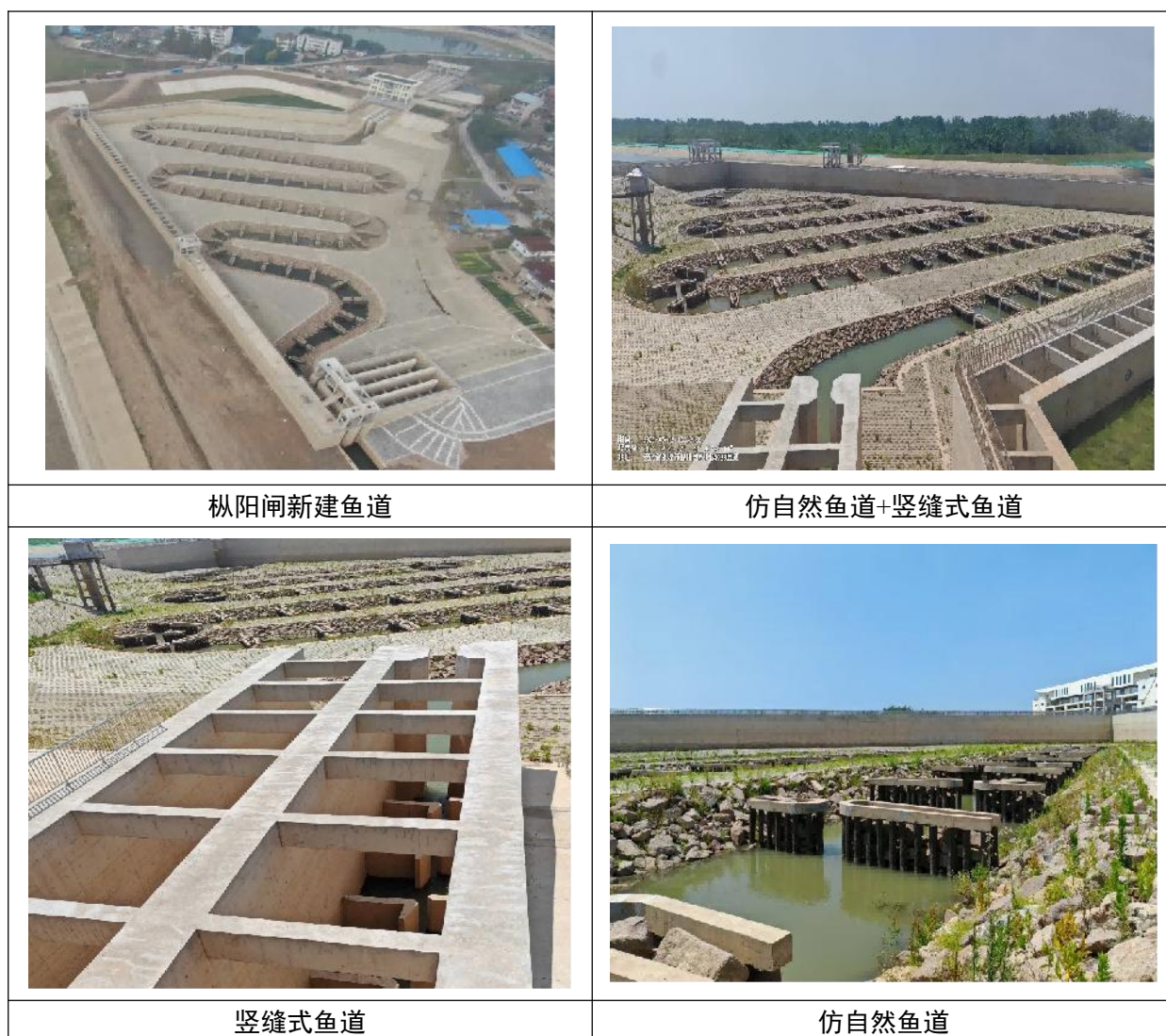
图 4.3-3 枞阳引江枢纽过鱼设施照片
