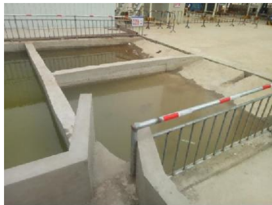
拌合站沉淀池
