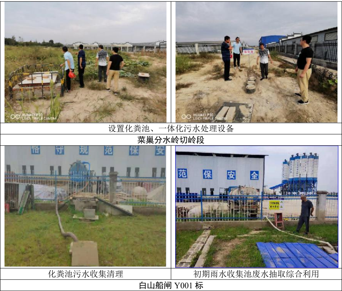
图 4.2-8 典型施工区生活污水处理措施
