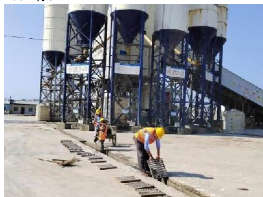
拌合站排水沟
