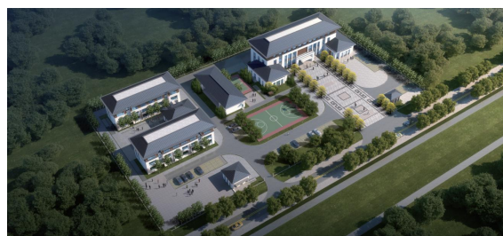
庐江枢纽管理用房
