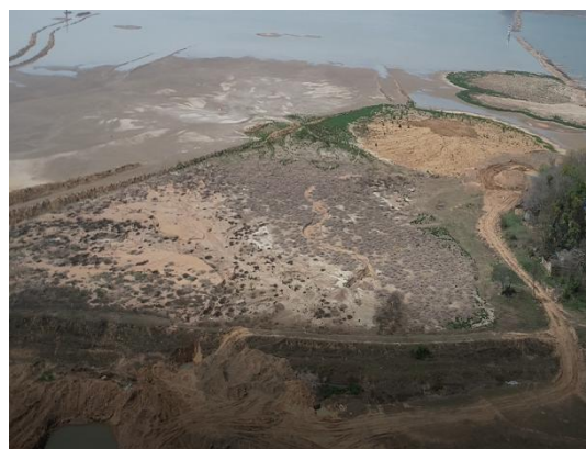
抬洲降滩区域施工后
