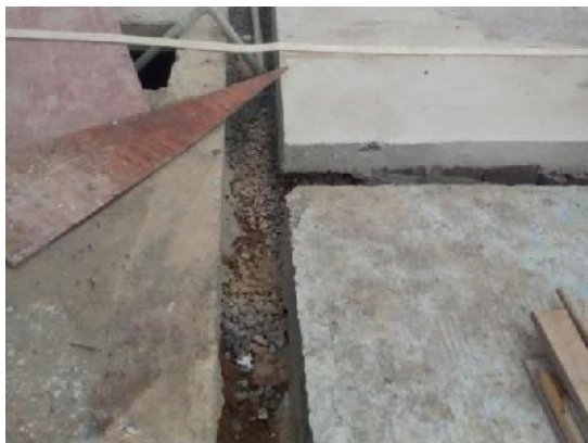
拌合站排水沟
