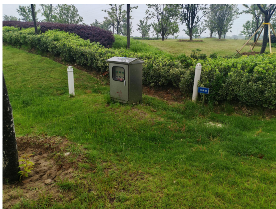
庐江船闸化粪池
