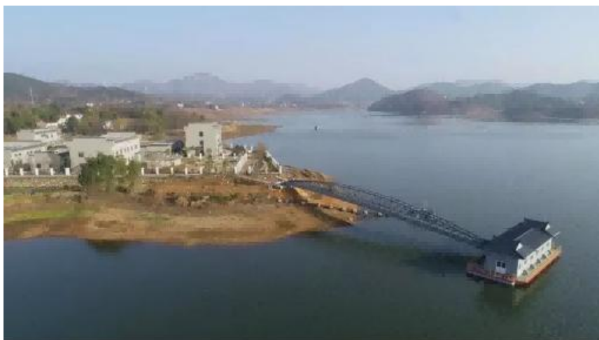
图 4.2-9 庐江县新自来水厂取水泵房
