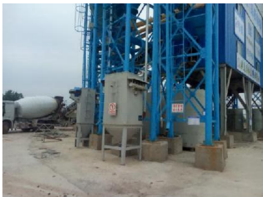
料仓配套安装除尘器
