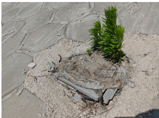
枞阳船闸化粪池
