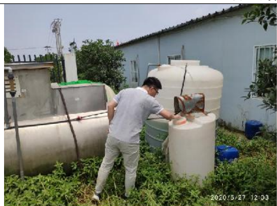
安装一体化污水处理设备
