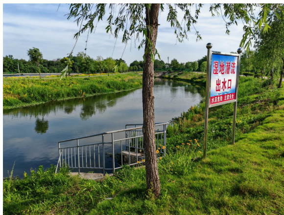
潜流湿地出水口
