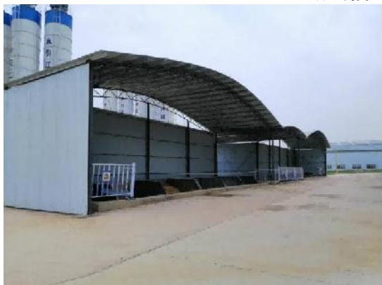
混凝土拌合站
