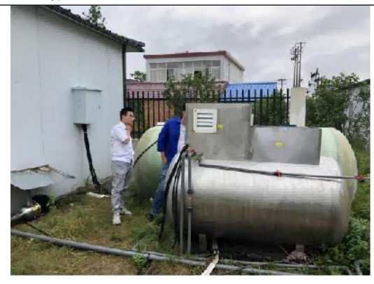
安装一体化污水处理设备
