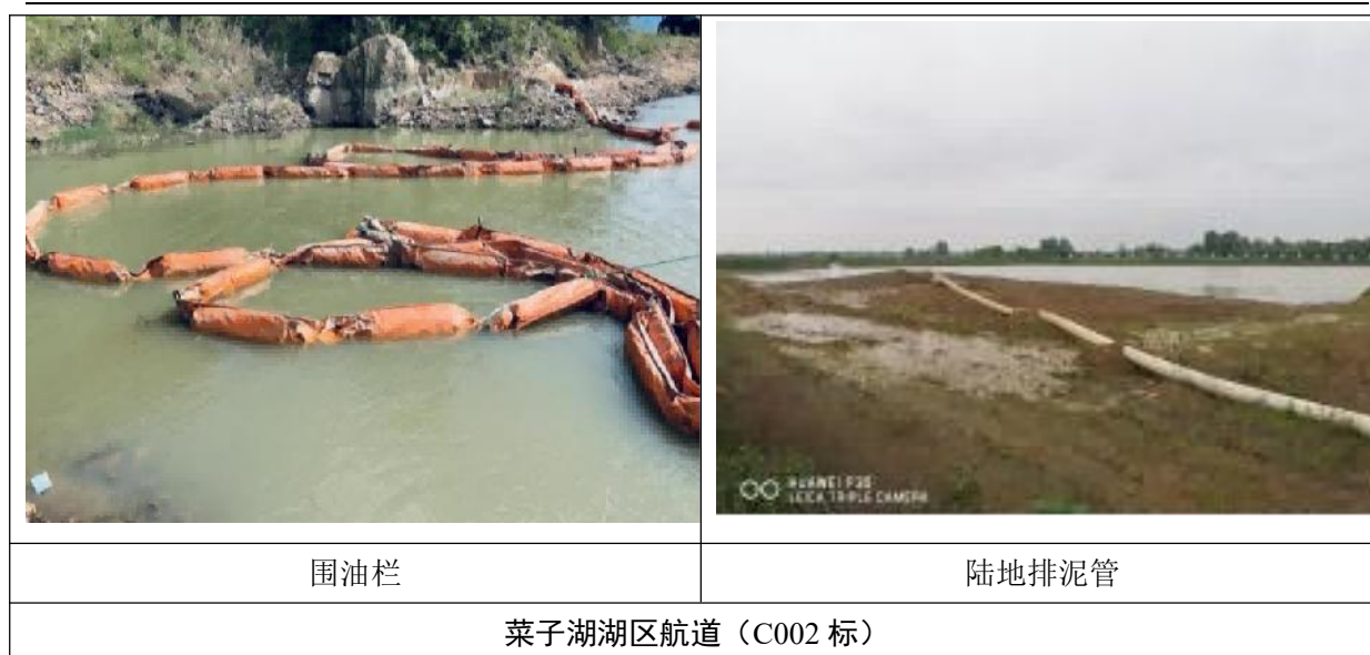
图 4.2-1 典型施工区疏浚及排泥照片
