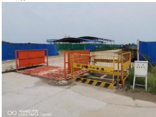
车辆冲洗设施及沉淀池 小合分线（Y003 标）
