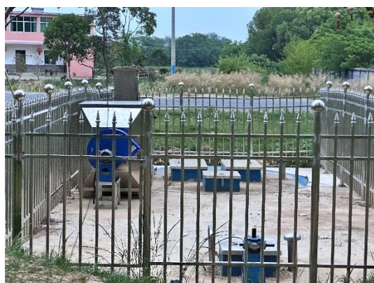
小墩安置点污水泵站
