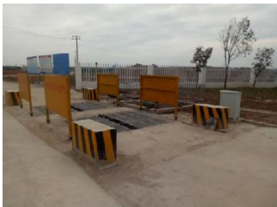
进出口处设置车辆冲洗设施及循环水池 枞阳引江枢纽（C001 标）
