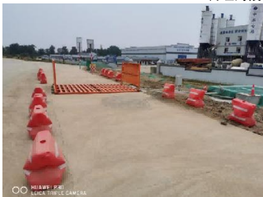
车辆冲洗设施及沉淀池 孔城河段（C003-1 标）
