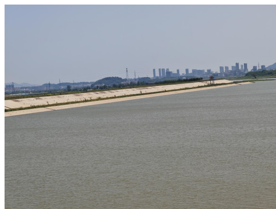
图 4.11-4 河道硬化现场照片
