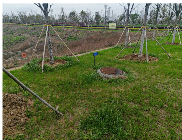
白山控制闸化粪池
