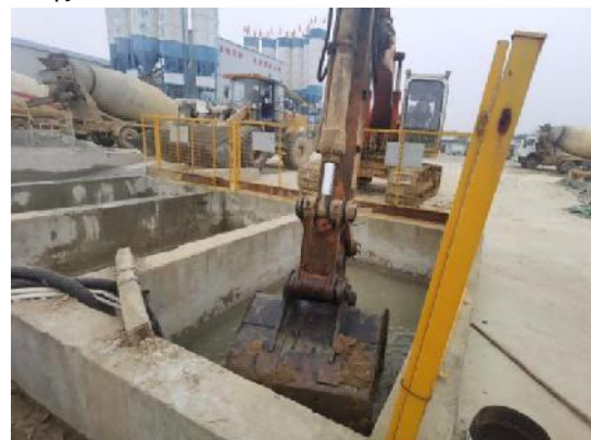
三级沉淀池沉渣清理
