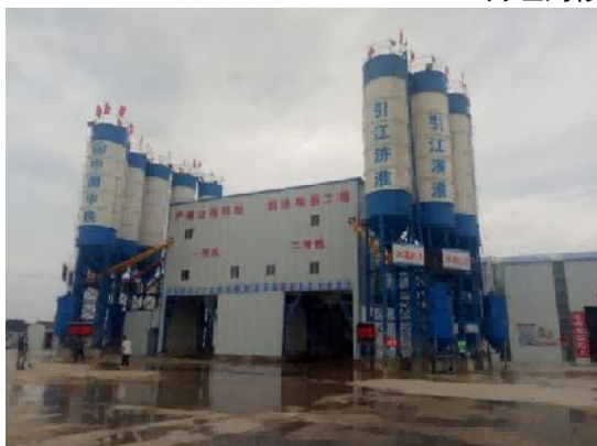
混凝土拌合站
