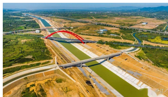
舒庐干渠渡槽
