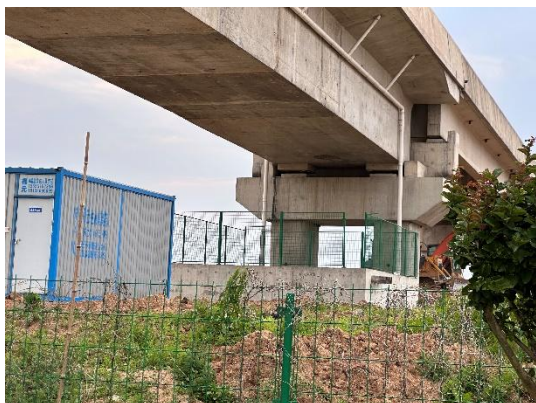
陈祠闸桥事故应急池
