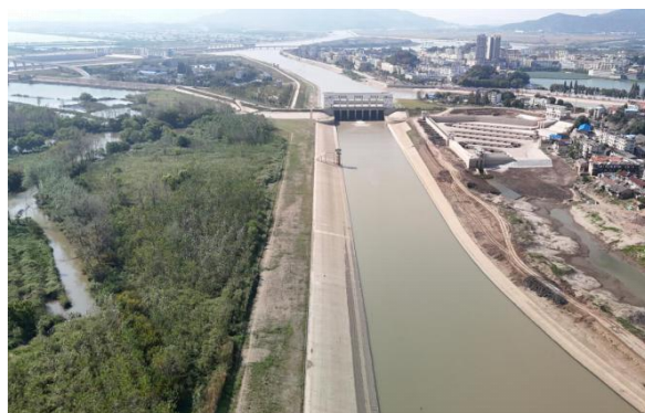
枞阳节制闸及长河河道
