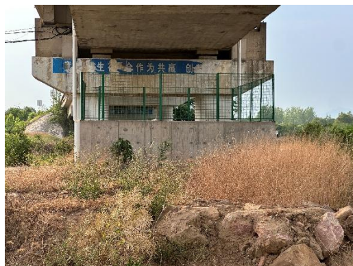
X078 庙王大桥事故应急池
