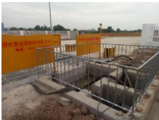
进出口处设置车辆冲洗设施及循环水池 枞阳引江枢纽（C001 标）
