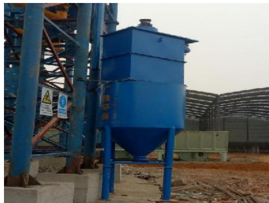
料桶配套安装除尘器
